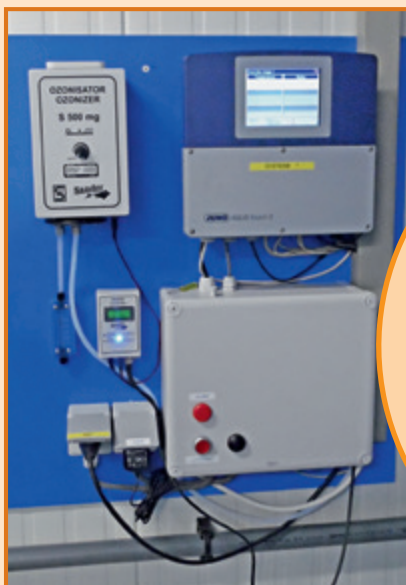
JUMO AQUIS touch stuurt en monitort de gehele installatie. Samen gemonteerd met een ozon generator.
