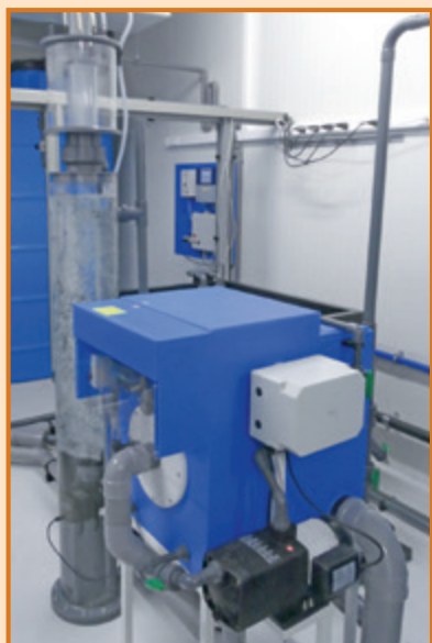
Onderdeel van filtersysteem, zelfreinigend drumfilter voor mechanische reiniging van vaste stoffen in viswater.
