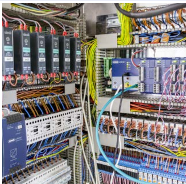
Het JUMO mTRON systeem aan het werk. Linksonder (het blauwe kastje) de voeding. Verder de CPU, de diverse modules, I/O kaarten, een aantal (analoge) PT-100 ingangen. De pH-sensoren zijn digitaal.
