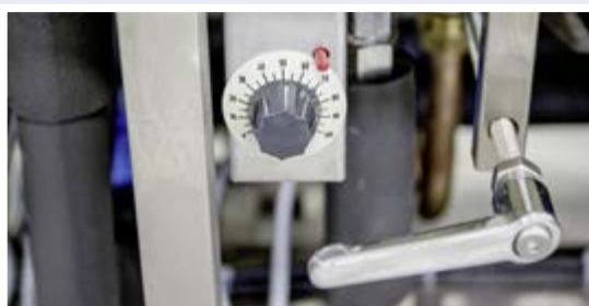
Een 'ouderwetse' analoge maximaalbeveiliging voorkomt dat de temperatuur een bepaalde kritische waarde overschrijdt.
