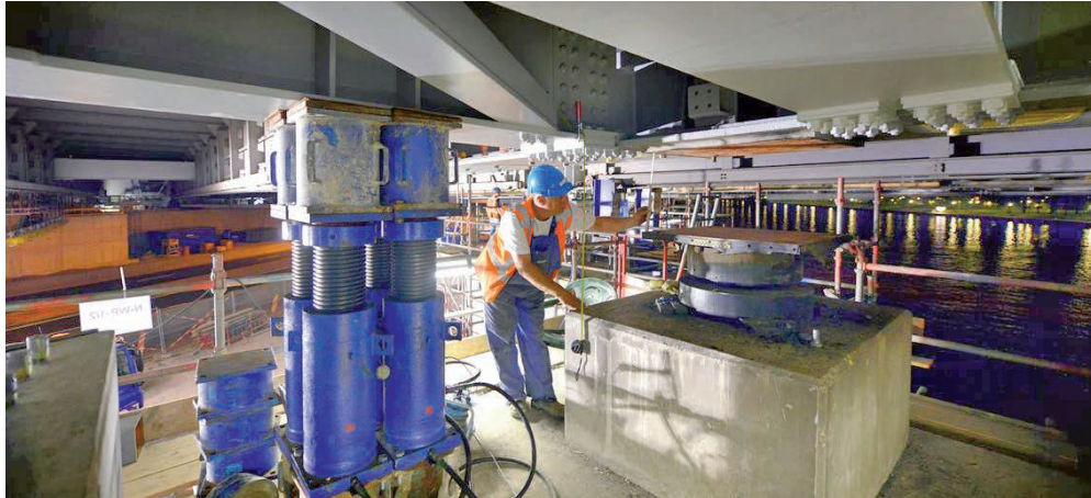
Om het zware beton te dragen, is versteviging van de onderbouw noodzakelijk.
