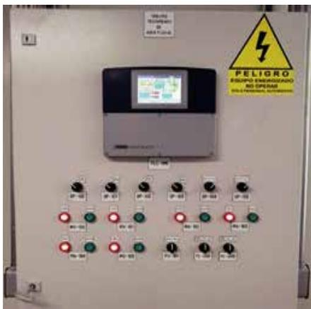
Figura 12. Ejemplo AQUIS touch S controlando una planta de tratamiento de aguas.
